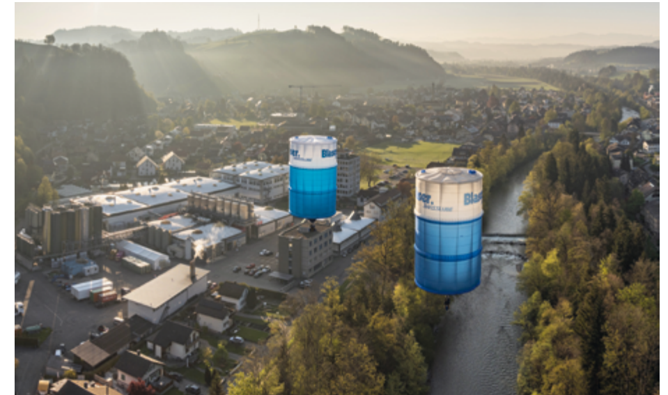
Blaser Swisslube Headquarter in Hasle-Rüegsau, Schweiz
