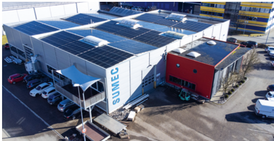
Fertigungshalle von SUMEC
